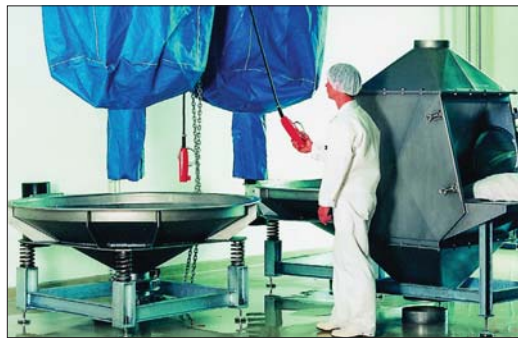
Bild 17: Vibrationseinrichtungen für die Entleerung von Big-Bags und Säcken
