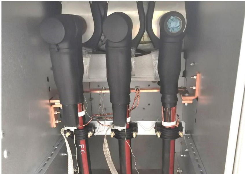
Fig. 2. Apartarrayos instalado en las celdas de media tensión de la subestación
